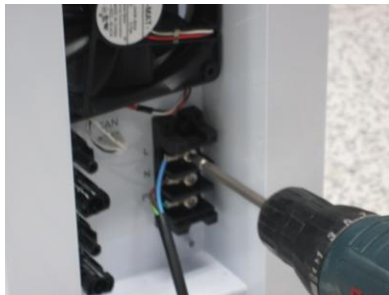
Anschlussmethode für L, N AC Draht
