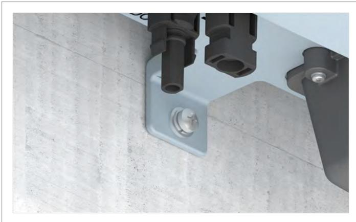
5. Den Wechselrichter wieder einhängen und unten festschrauben.
