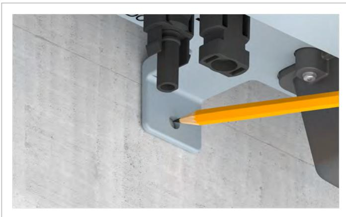
3. Die Bohrung für das Montageloch an der Unterseite des Wechselrichters anzeichnen und den Wechselrichter wieder abhängen.
